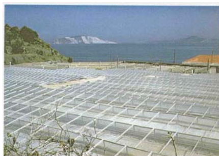
B6 Destillationsanlage zur Entsalzung von Meerwasser auf Porto Santo. Sonnenstrahlen liefern die erforderliche Wärme
